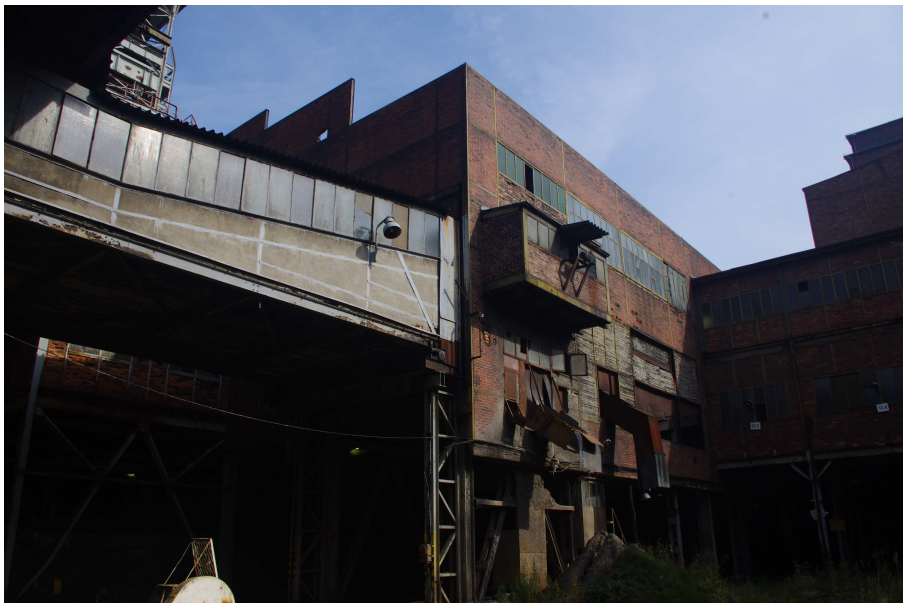
Fot. 22 Budynek główny Zakładu Przeróbki Mechanicznej Węgla/ Pomosty transportowe - oparcie pomostu transportowego na segmencie nr 9 ZPMW - widok od strony południowo-zachodniej.
