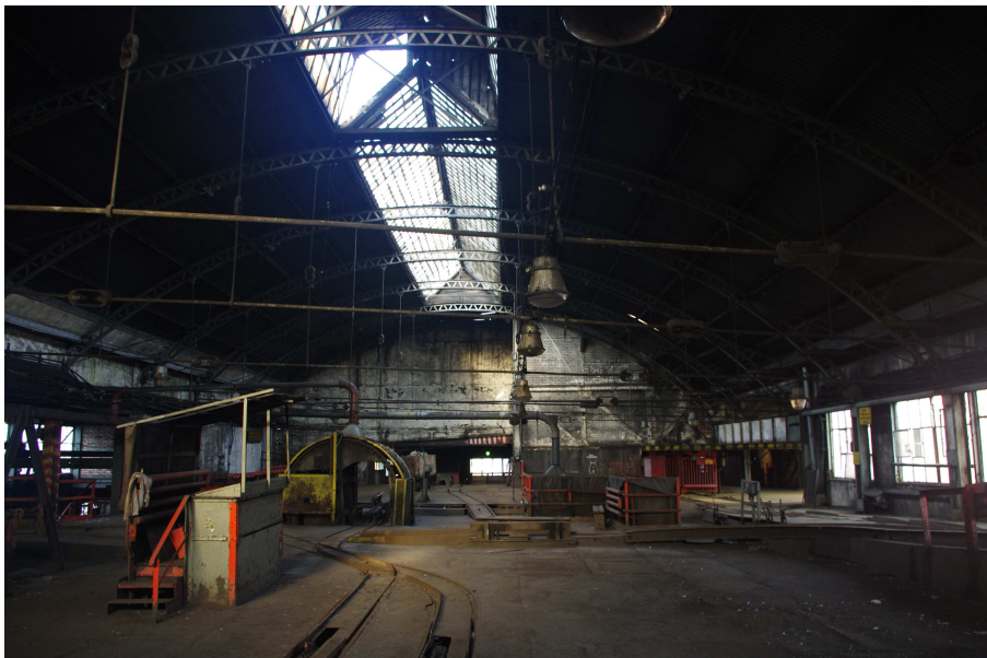
Fot. 4 Budynek główny Zakładu Przeróbki Mechanicznej Węgla - wewnątrz segmentu nr 1.
