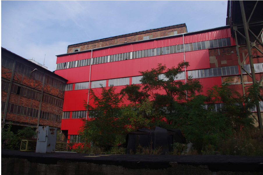
Fot. 39 Budynek główny Zakładu Przeróbki Mechanicznej Węgla - widok od strony południowej, na pierwszym planie segment nr 19.
