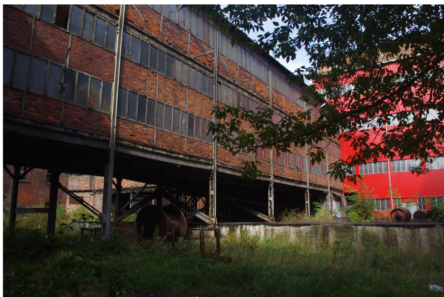
Fot. 52 Pomost stalowy (ze zwatów na przeróbkę) - widok od strony południowo-wschodniej.
