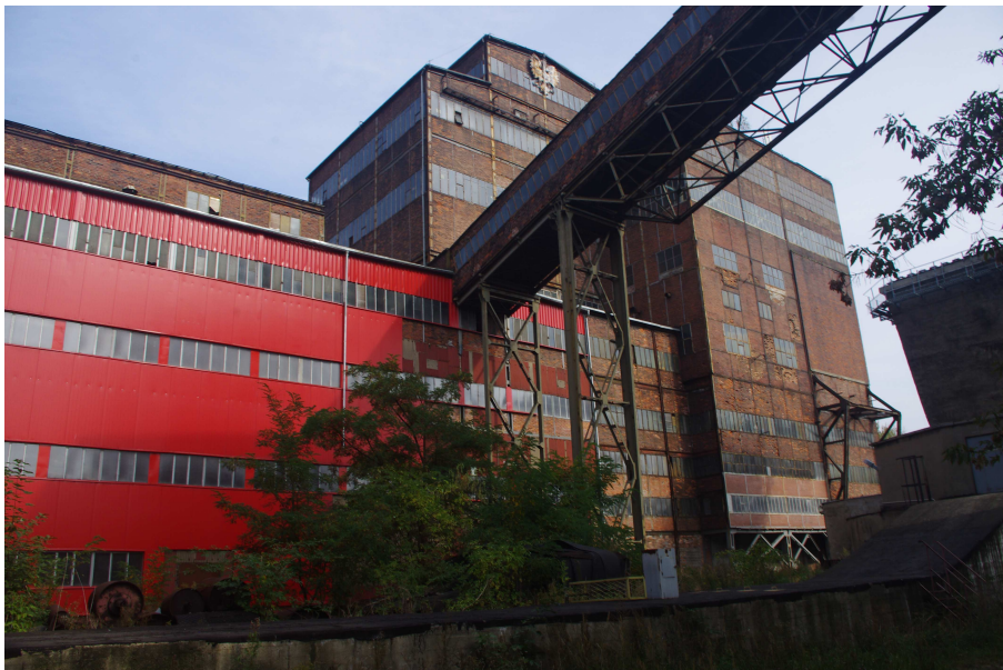
Fot. 32 Budynek główny Zakładu Przeróbki Mechanicznej Węgla/ Pomost stalowy - widok od strony południowo-zachodniej, widoczne segment nr 19; 20; 14; 21 oraz oparcie pomostu stalowego na ZPMW.
