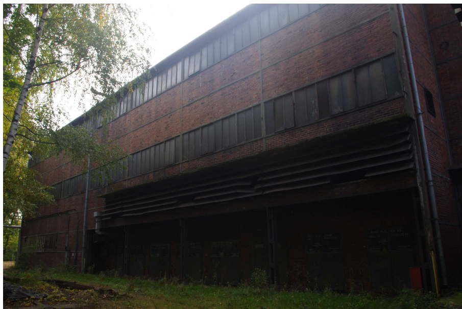
Fot. 12 Budynek główny Zakładu Przeróbki Mechanicznej Węgla - widok od strony północno-wschodniej na segment nr 5.
