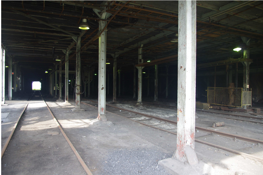
Fot. 43 Budynek główny Zakładu Przeróbki Mechanicznej Węgla - torowiska pod budynkiem.
