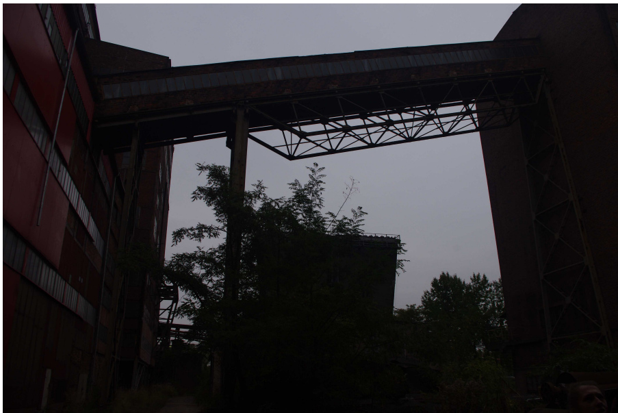
Fot. 60 Pomost stalowy - widok od strony zachodniej.
