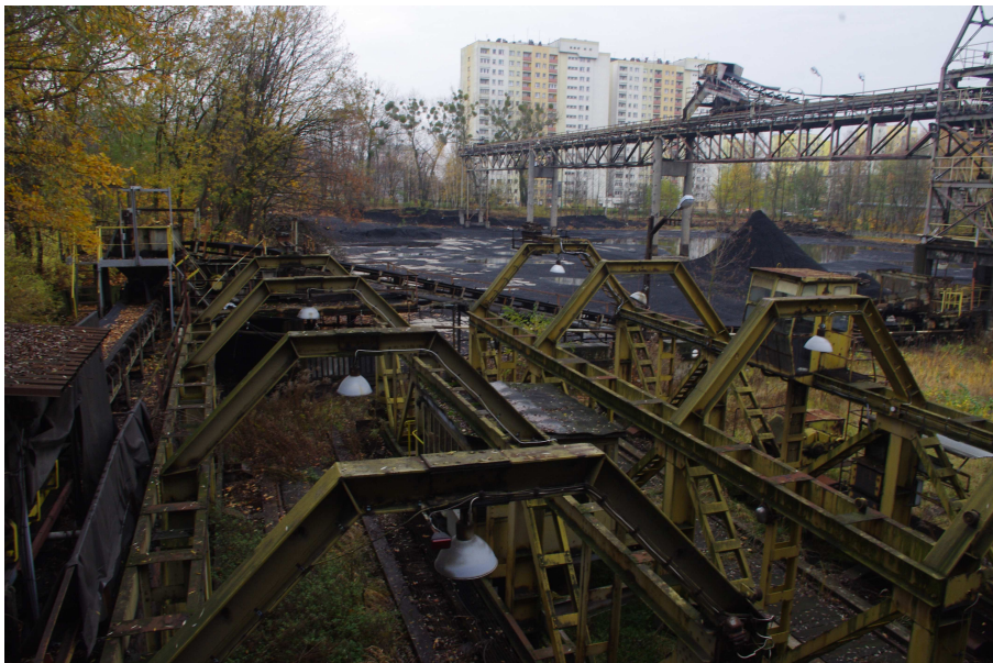
Fot. 46 Przesuwnia wagonowa z taśmociągiem.
