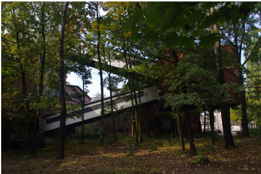
Fot. 50 Most przenośnikowy - widok od strony wschodniej.
