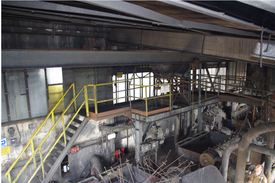
Fot. 41 Budynek główny Zakładu Przeróbki Mechanicznej Węgla - wewnątrz segmentu nr 21.
