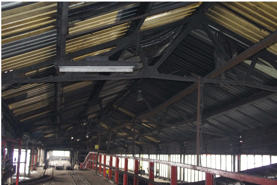
Fot. 54 Pomost stalowy (ze zwałów na przeróbkę) - wewnątrz.
