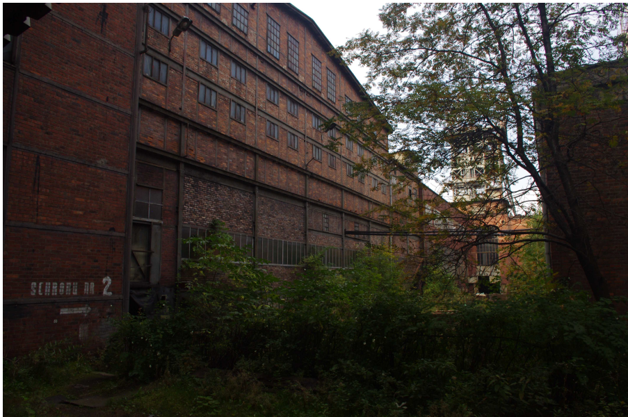
Fot. 6 Budynek główny Zakładu Przeróbki Mechanicznej Węgla - widok od strony północno-wschodniej na segmenty nr 4; 3; 2; 1, w głębi budynek nadszybia szybu „Rejtan”.
