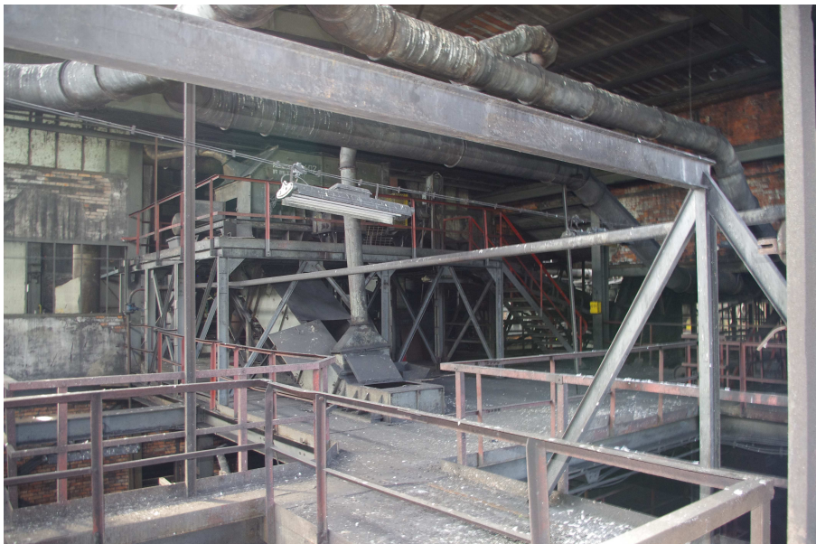
Fot. 10 Budynek główny Zakładu Przeróbki Mechanicznej Węgla - poziom +15.10 w segmencie nr 4.
