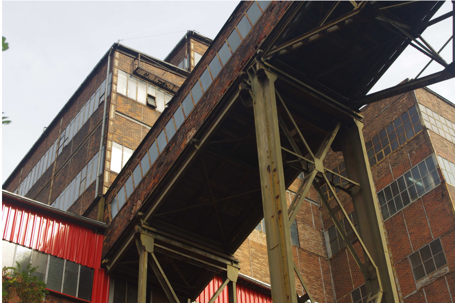
Fot. 61 Pomost stalowy - widok od strony południowej.
