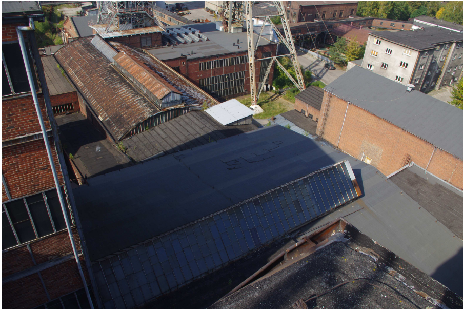
Fot. 25 Budynek główny Zakładu Przeróbki Mechanicznej Węgla - widok na dachy segmentów nr 3; 2 i 1.
