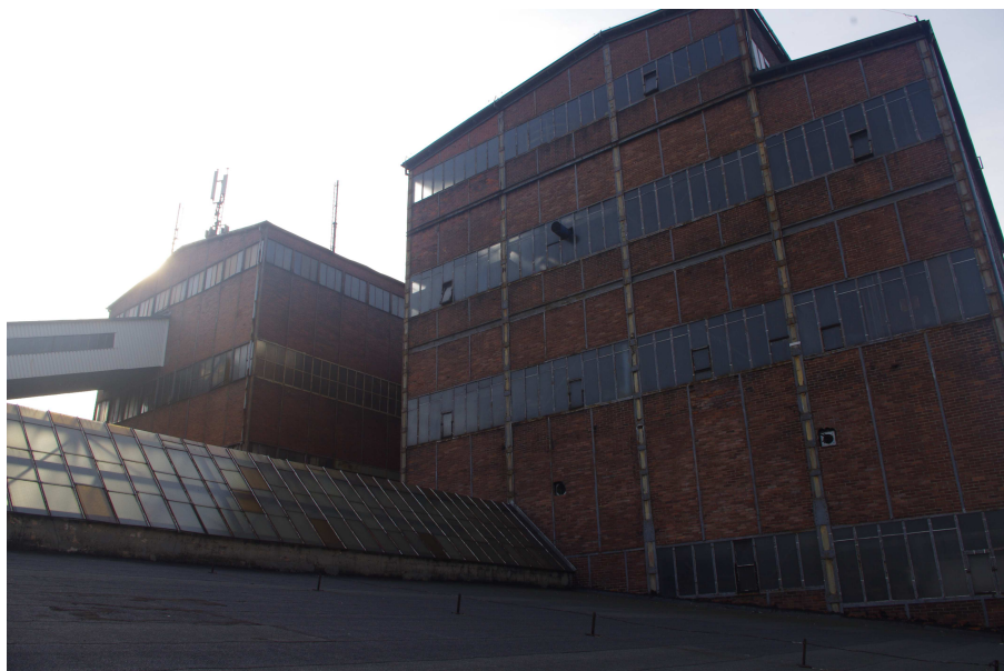
Fot. 8 Budynek główny Zakładu Przeróbki Mechanicznej Węgla - widok od strony północnej na segmenty nr 14 i 16, ponad dachem segmentu nr 3.
