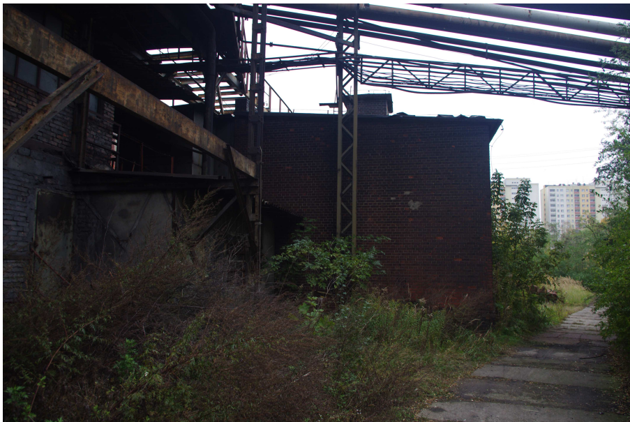
Fot. 58 Warsztat przeróbki mechanicznej TMN - widok od strony zachodniej.
