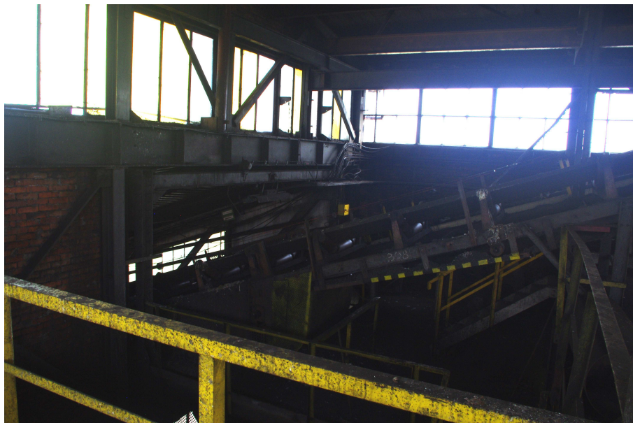
Fot. 35 Budynek główny Zakładu Przeróbki Mechanicznej Węgla/ Most przenośnikowy - „wlot” mostów przenośnikowych do segmentu nr 16 ZPMW.
