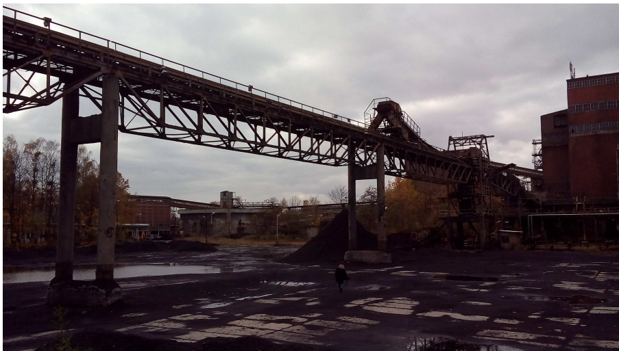
Fot. 44 Most przesypowy węgla z taśmociągami - widok od strony północno-wschodniej.
