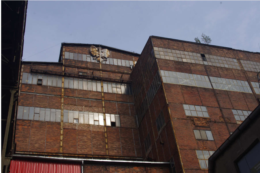
Fot. 33 Budynek główny Zakładu Przeróbki Mechanicznej Węgla - widok od strony południowej na segmenty nr 14 i 21.
