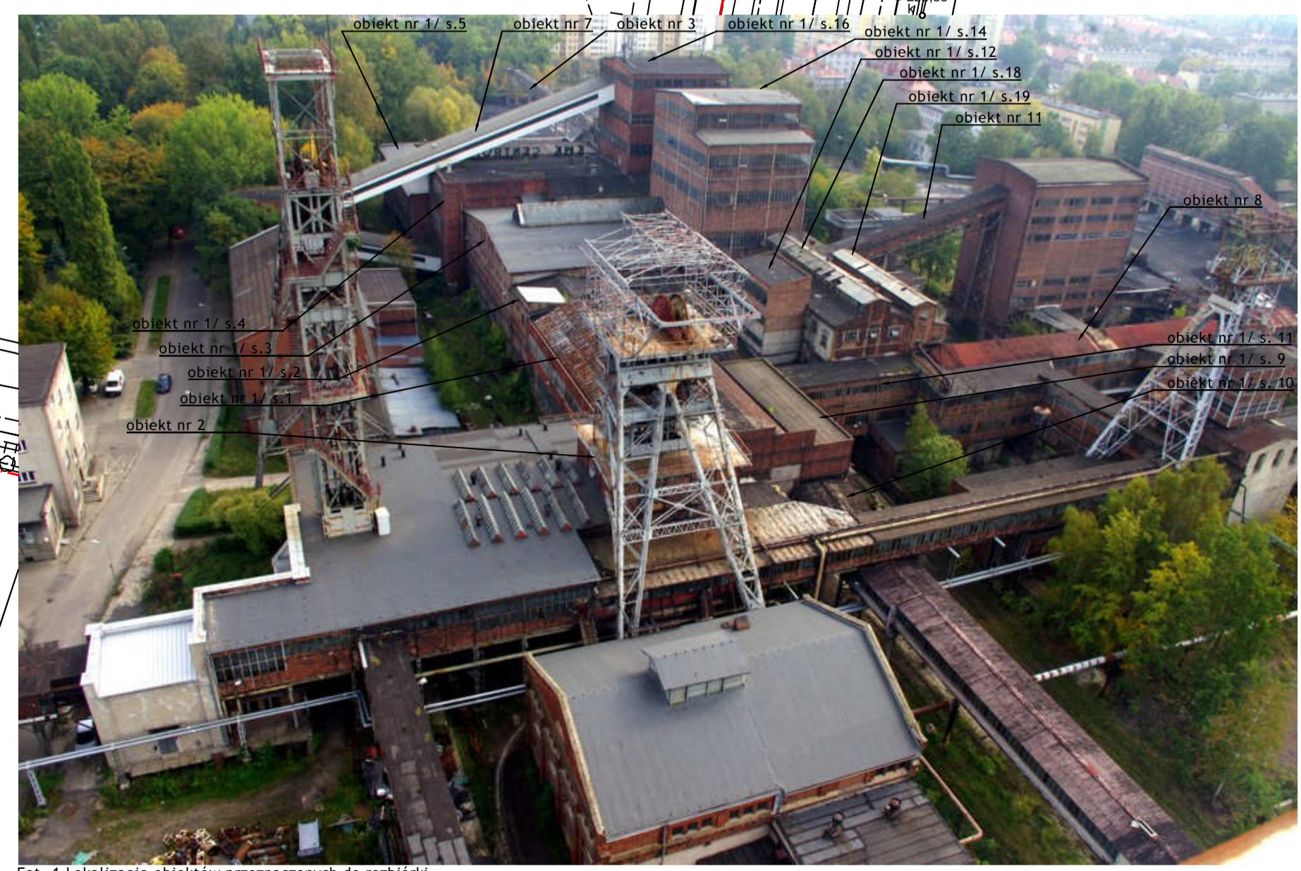
Fot. 1 Lokalizacja obiektów przeznaczonych do rozbiórki
