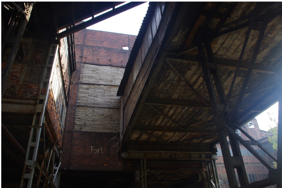
Fot. 24 Budynek główny Zakładu Przeróbki Mechanicznej Węgla/ Pomosty transportowe - oparcie pomostu transportowego na segmencie nr 9 ZPMW - widok od strony zachodniej.
