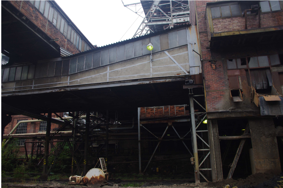
Fot. 59 Pomosty transportowe - widok od strony południowej.
