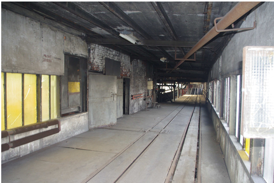
Fot. 30 Budynek główny Zakładu Przeróbki Mechanicznej Węgla - segment nr 11.
