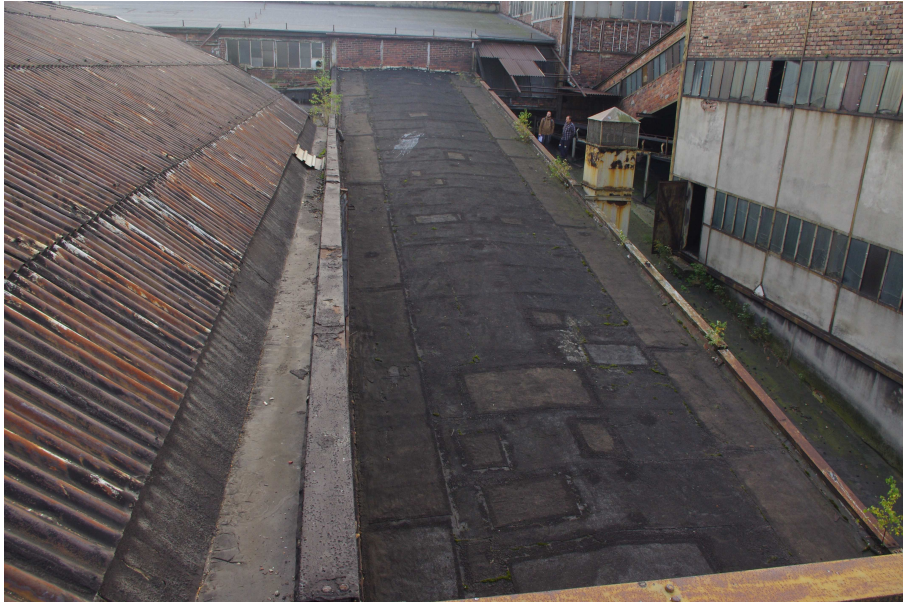
Fot. 27 Budynek główny Zakładu Przeróbki Mechanicznej Węgla - dach segmentu nr 10.
