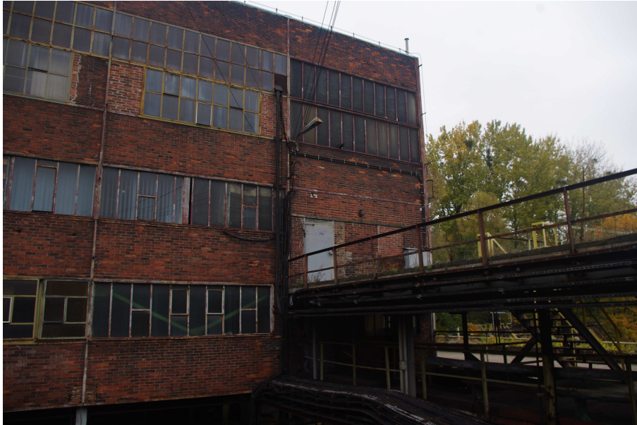
Fot. 21 Budynek główny Zakładu Przeróbki Mechanicznej Węgla - widok z rampy (ze strony południowej) na segment nr 8 - wejście główne do budynku ZPMW.
