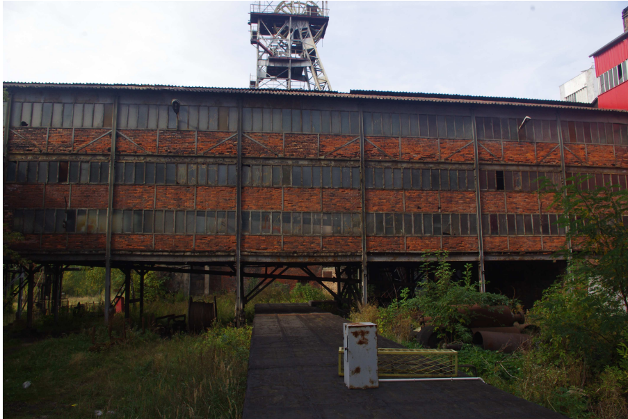
Fot. 53 Pomost stalowy (ze zwałów na przeróbkę) - widok od strony wschodniej.
