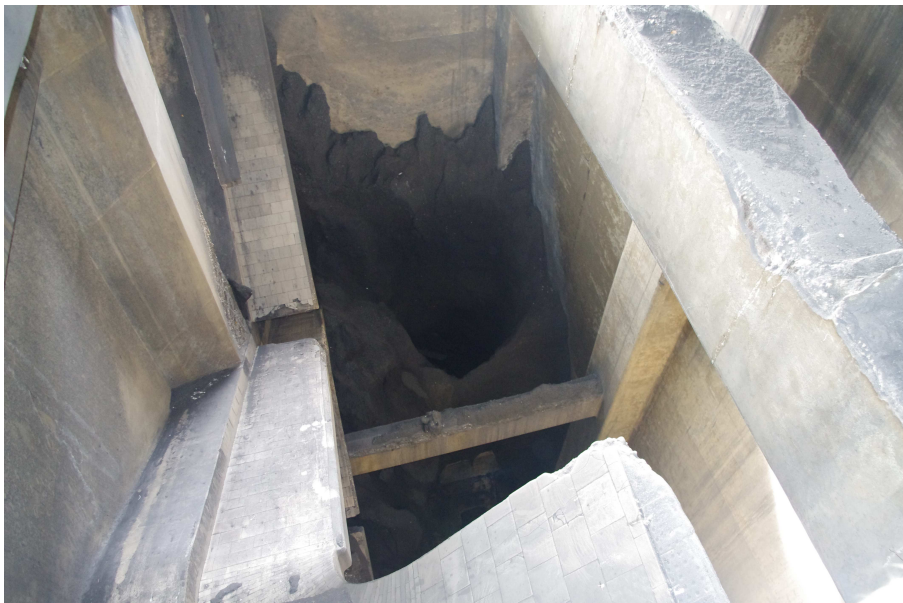
Fot. 34 Budynek główny Zakładu Przeróbki Mechanicznej Węgla - zbiorniki żelbetowe w segmencie nr 16.
