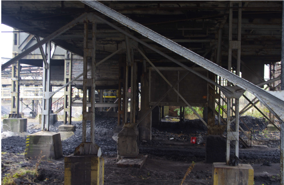
Fot. 55 Pomost stalowy (ze zwatów na przeróbkę) - posadowienie.
