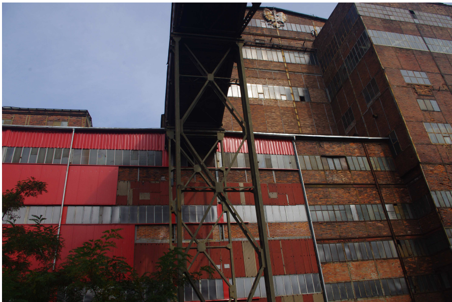
Fot. 40 Budynek główny Zakładu Przeróbki Mechanicznej Węgla/ Pomost stalowy - widok od strony południowej, na pierwszym planie segment nr 20 i oparcie na nim pomostu stalowego.
