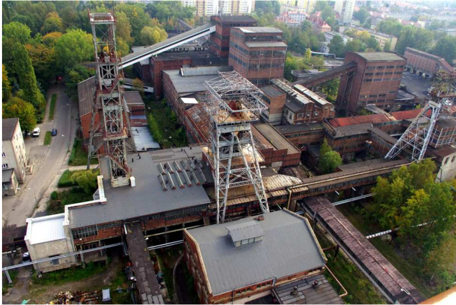
Fot. 1 Widok ogólny obiektów przeznaczonych do rozbiórki - na pierwszym planie szymbel „Rejtan”, za nim budynek główny Zakładu Przeróbki Mechanicznej Węgla.
