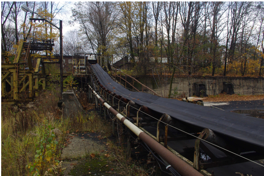
Fot. 48 Stacja zwrotna - widok od strony południowej.
