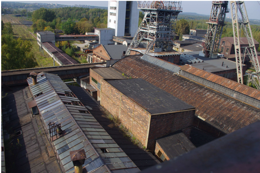
Fot. 2 Budynek główny Zakładu Przeróbki Mechanicznej Węgla - widok na dachy segmentów nr 18; 12; 10 i 1.
