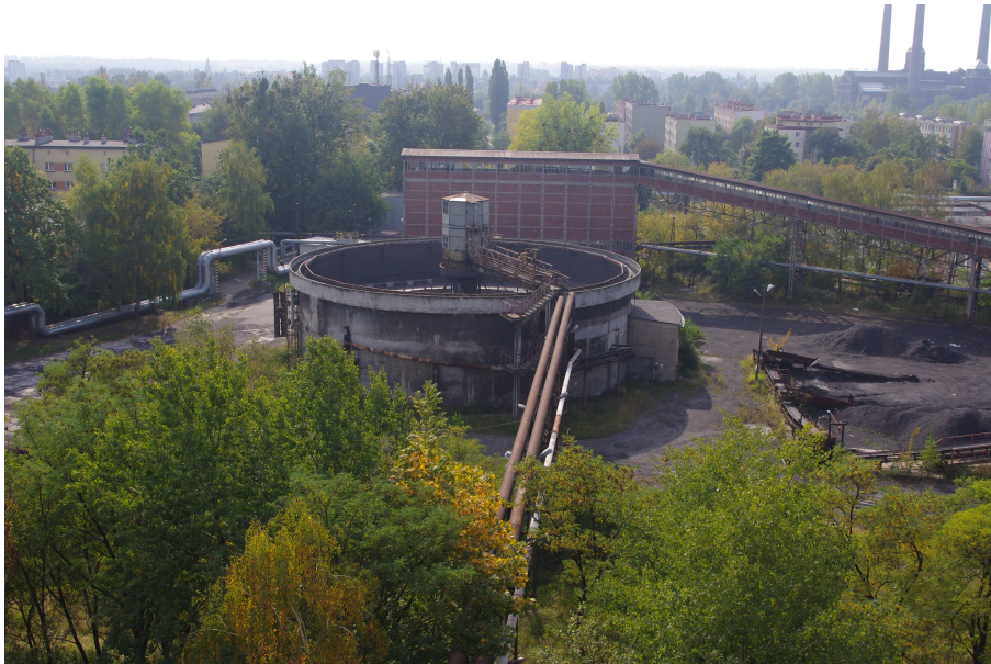
Fot. 47 Odmulnik Dorra z rurociągami technologicznymi - widok od strony północnej.
