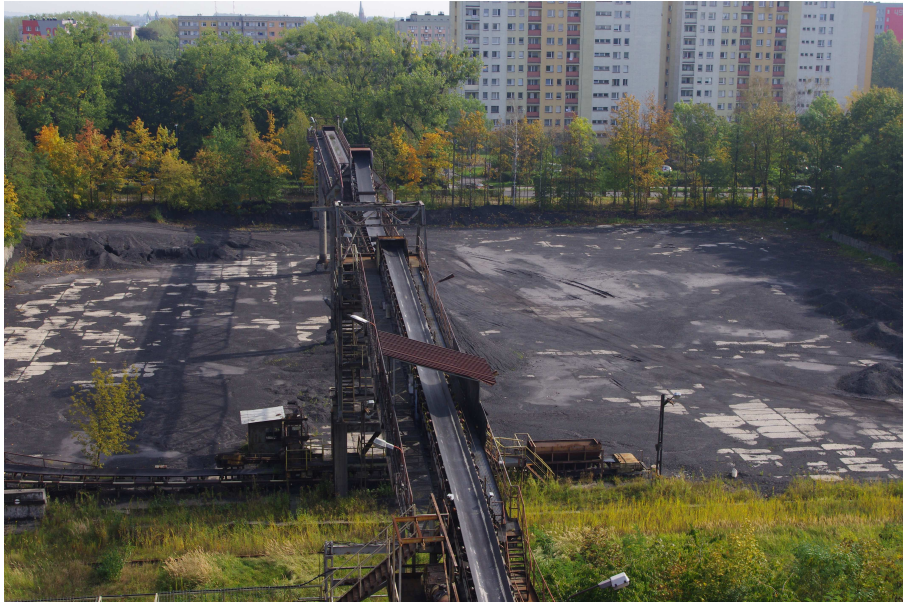
Fot. 45 Most przesyowy węgla z taśmociągiem - widok od strony zachodniej.
