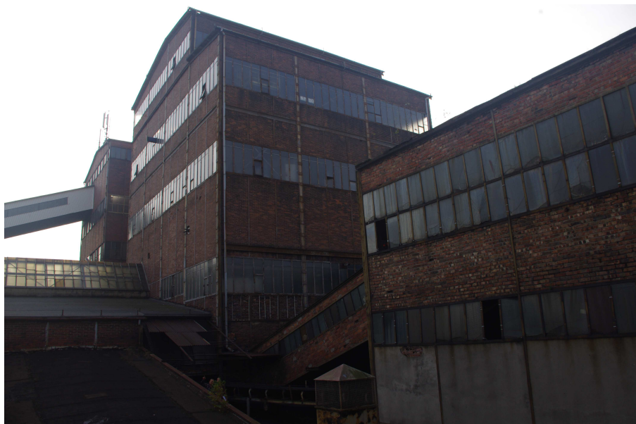
Fot. 7 Budynek główny Zakładu Przeróbki Mechanicznej Węgla - widok od strony północno-zachodniej na segmenty nr 12; 13 i 14.
